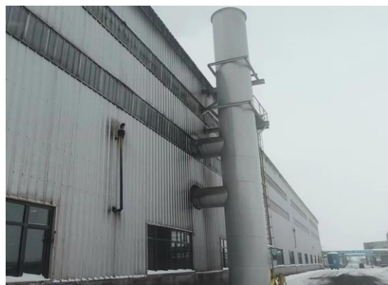
热风炉排气筒
