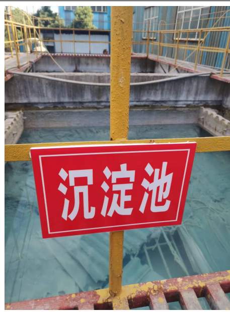
污水处理站沉淀池
