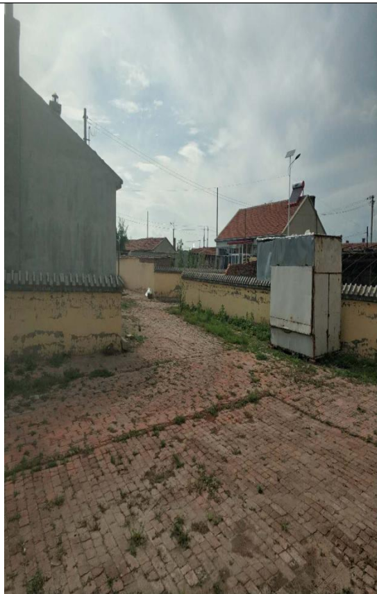
厂区西侧-居民住宅
