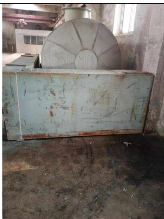
盐酸储罐围堰
