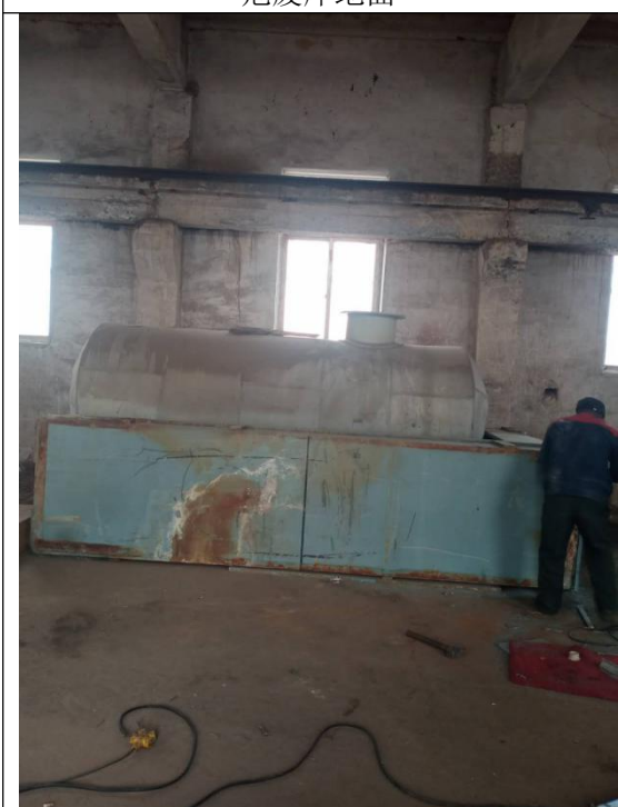
盐酸储罐围堰
