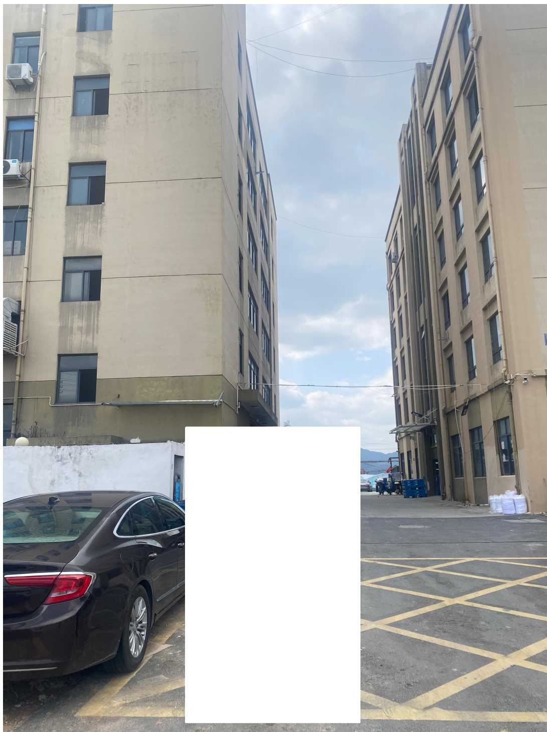
附图 12 编制主持人现场勘察照片
