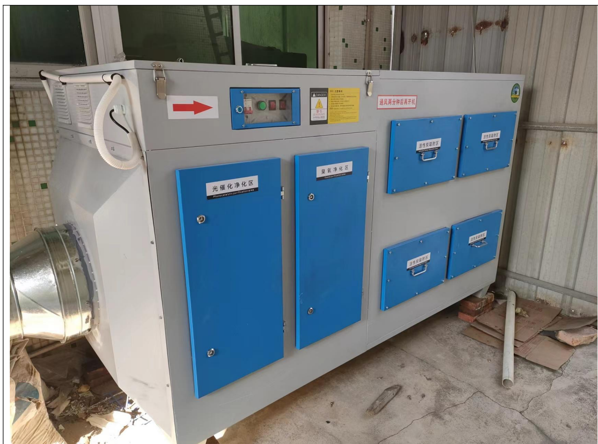
UV 光解+活性炭吸附” 有机废气处理设施
