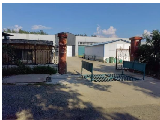
运输车辆冲洗装置
