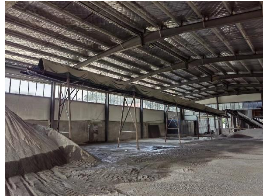
物料封闭式输送廊道
