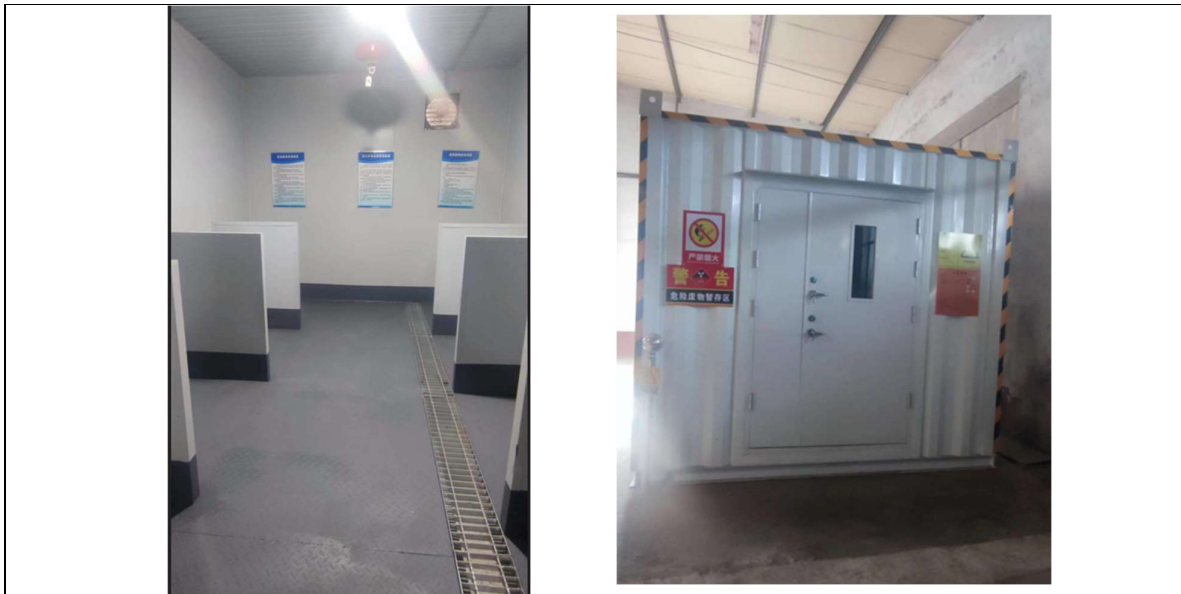
图4-3 本项目危废间设置情况
