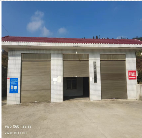
项目主体工程
