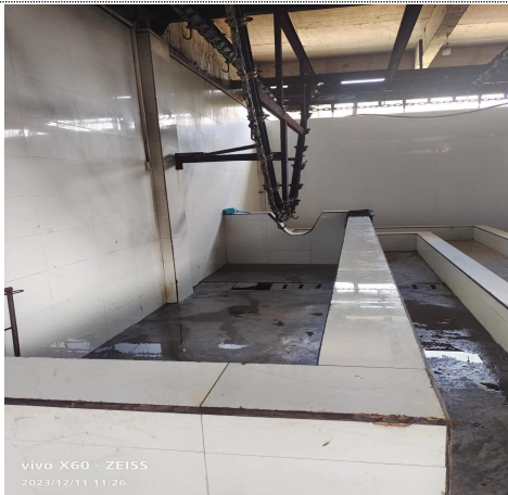
屠宰车间污水沟
