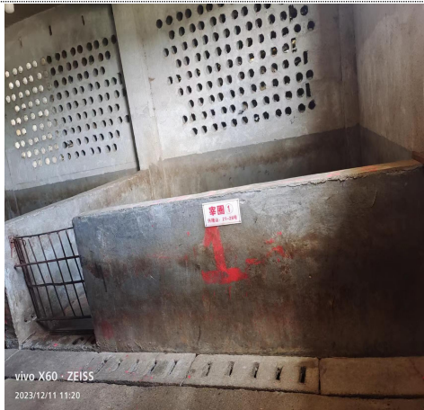
待宰车间污水沟
