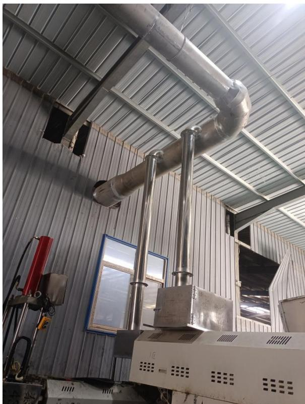
熔融加热废气收集设施
