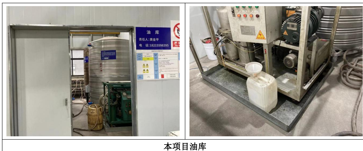
图 3-4 项目内油库现场照片
