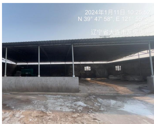
未拆除粪房（临时库房）
