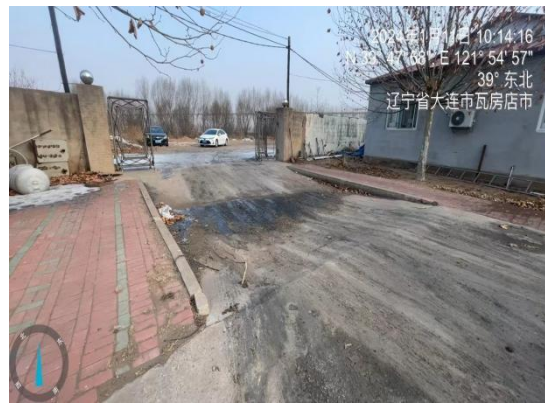
图 4-7 厂区大门消毒槽
