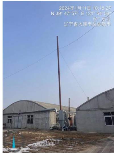
图 4-5 锅炉房排气筒
