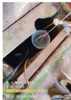
生活污水排放口
