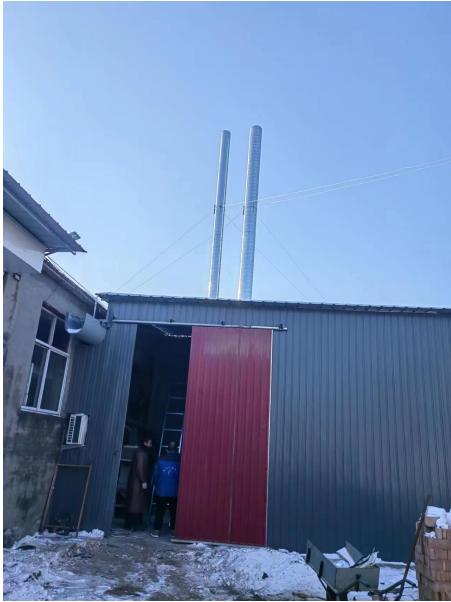
污染治理设施及排气筒照片
