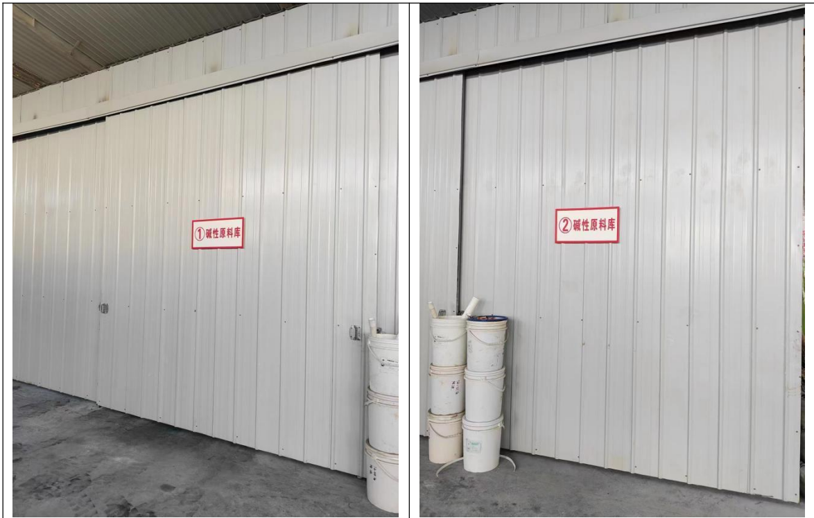
封闭的 1#碱性原料库
