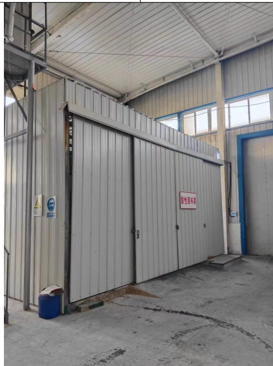
封闭的酸性原料库
