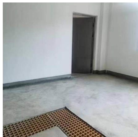
危废暂存间内部
