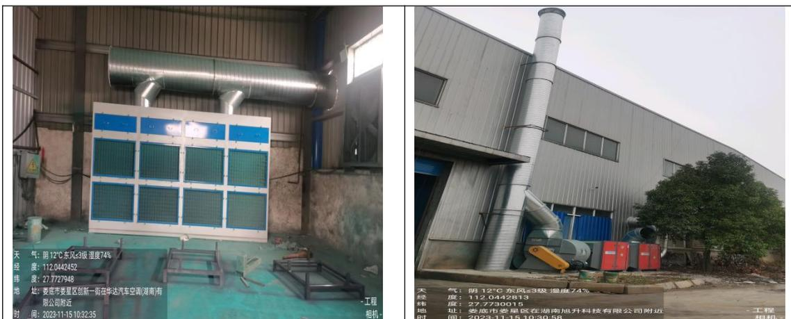
密闭喷漆房+负压收集+干式过滤柜（过滤棉）+二级活性炭吸附装置处理后
