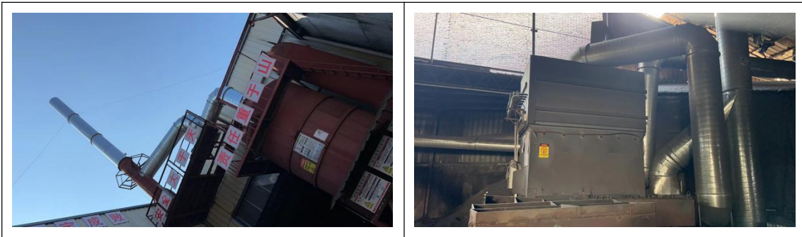
熔化浇注废气处理设施
