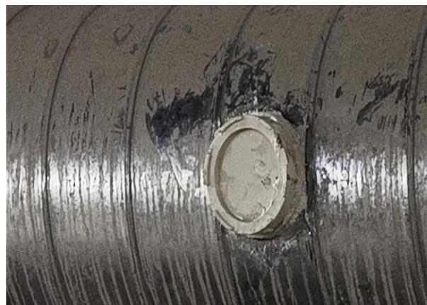
机器管道及检测孔
