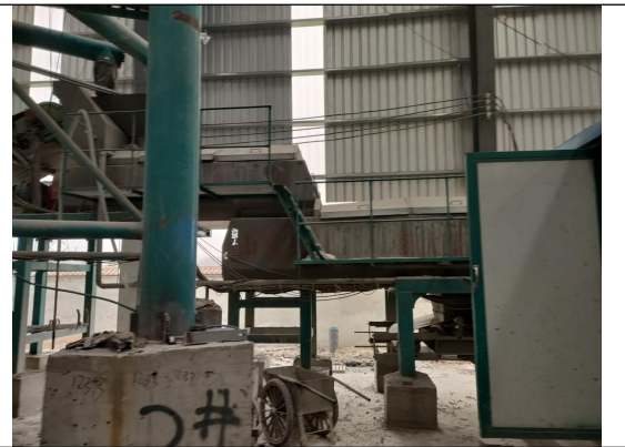
项目水稳生产线
