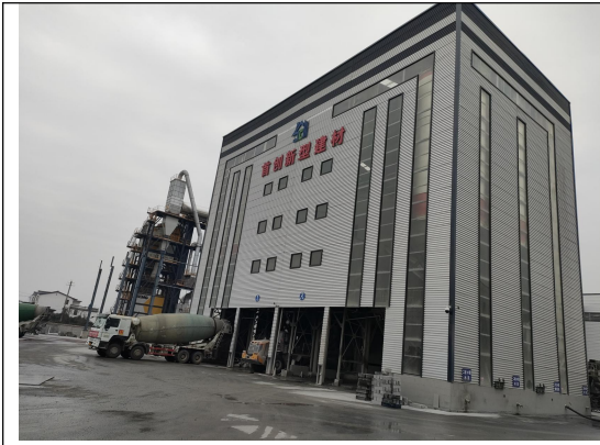
项目商砼生产线现状
