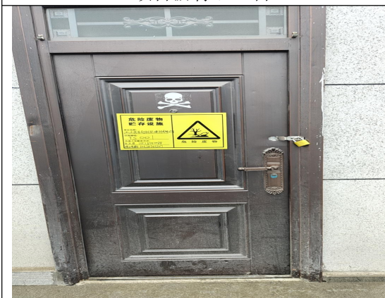
项目危废暂存间
