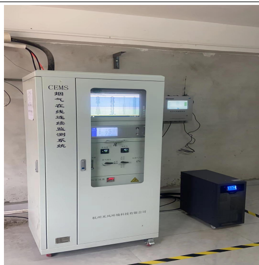
废气在线设备 (颗粒物、氮氧化物、二氧化硫)
