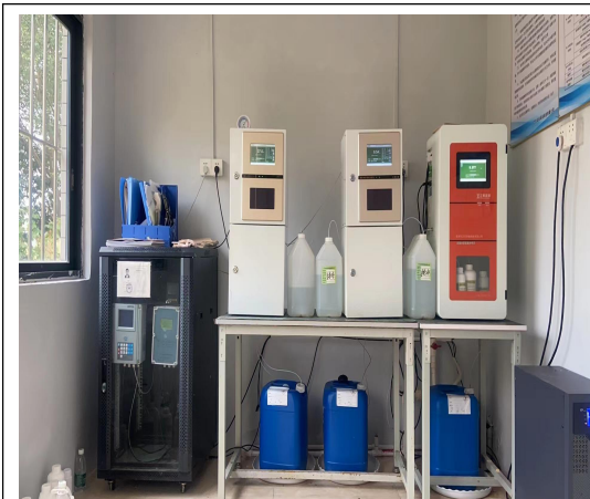
废水在线设备 (pH、氨氮、CODcr、流量、总氮)
