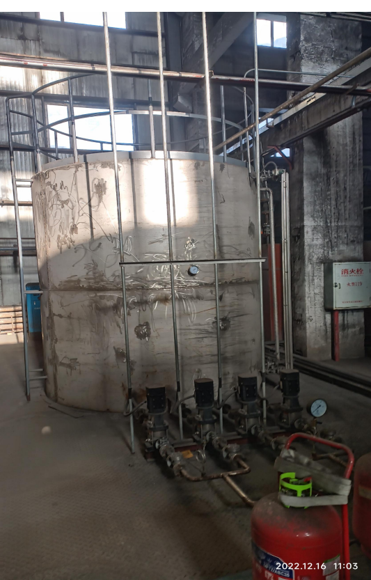
SNCR 脱硝设备
