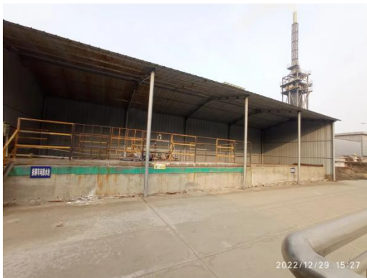
污水处理站-原水池
