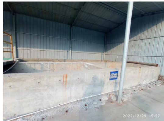
污水处理站-洗浴用水收集池
