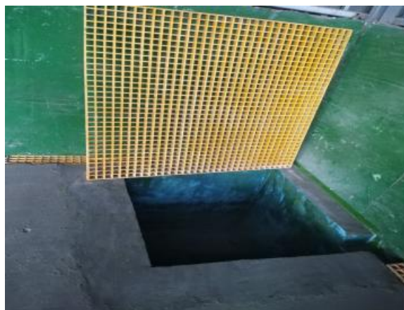
危废库地面沟槽
