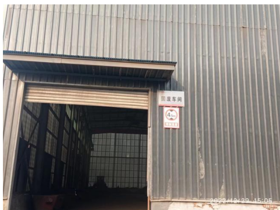
一般固废暂存库
