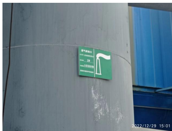
废气排放口标识
