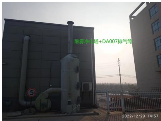
化实验室废气-处理及排放设施
