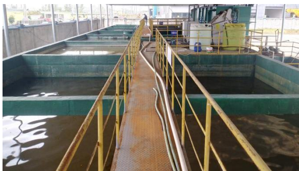
污水处理站-池体
