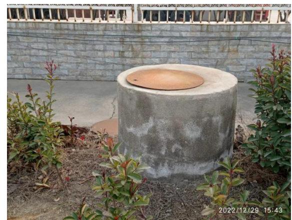
地下水监控井 (4)
