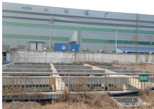
初期雨水收集池
