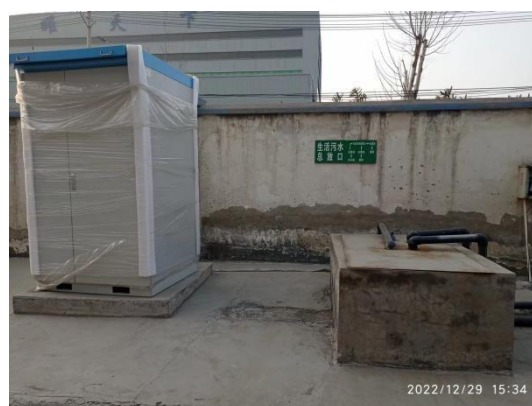
生活污水总排口
