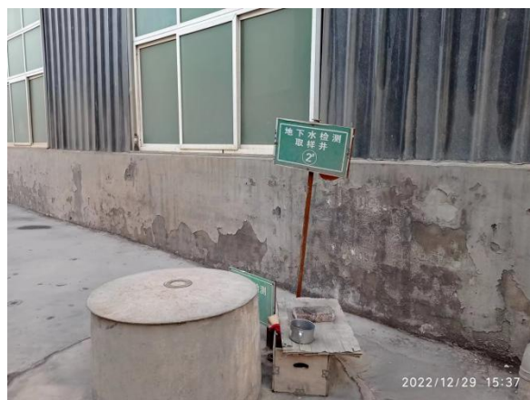
地下水监控井 (2)
