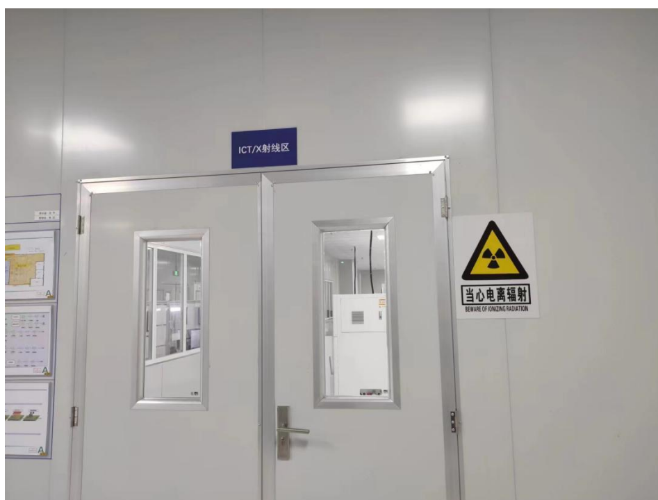
图 4-1 设备现场实景图片
