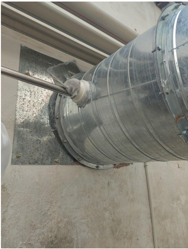
注塑工序废气处理前检测口 ©Q1
