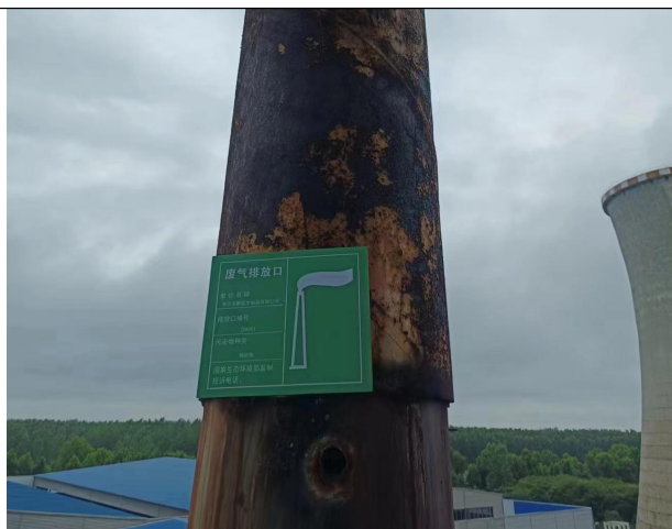
废气检测口及排放标识
