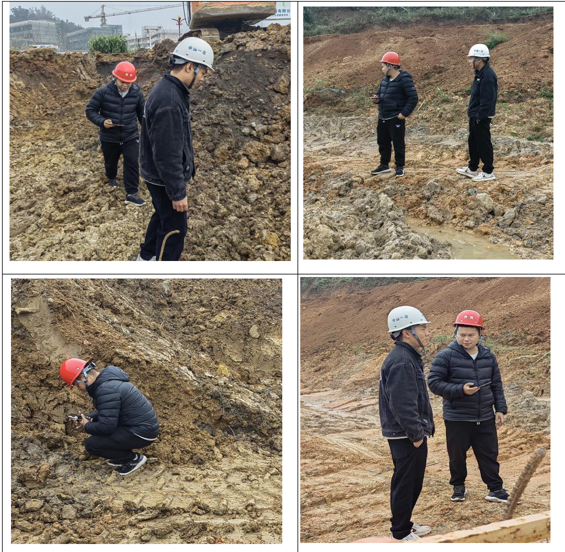
图 4.4-1 现场踏勘照片
