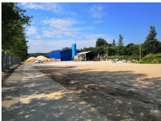
厂区运输道路硬化及绿化、原料库封闭
