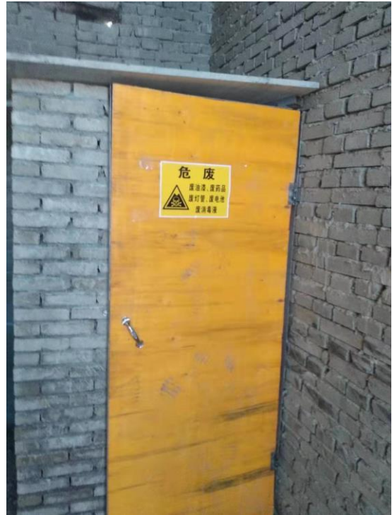
危险废物暂存间
