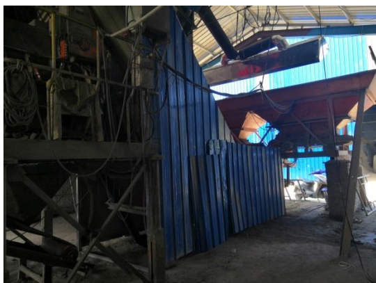
配料工段封闭
